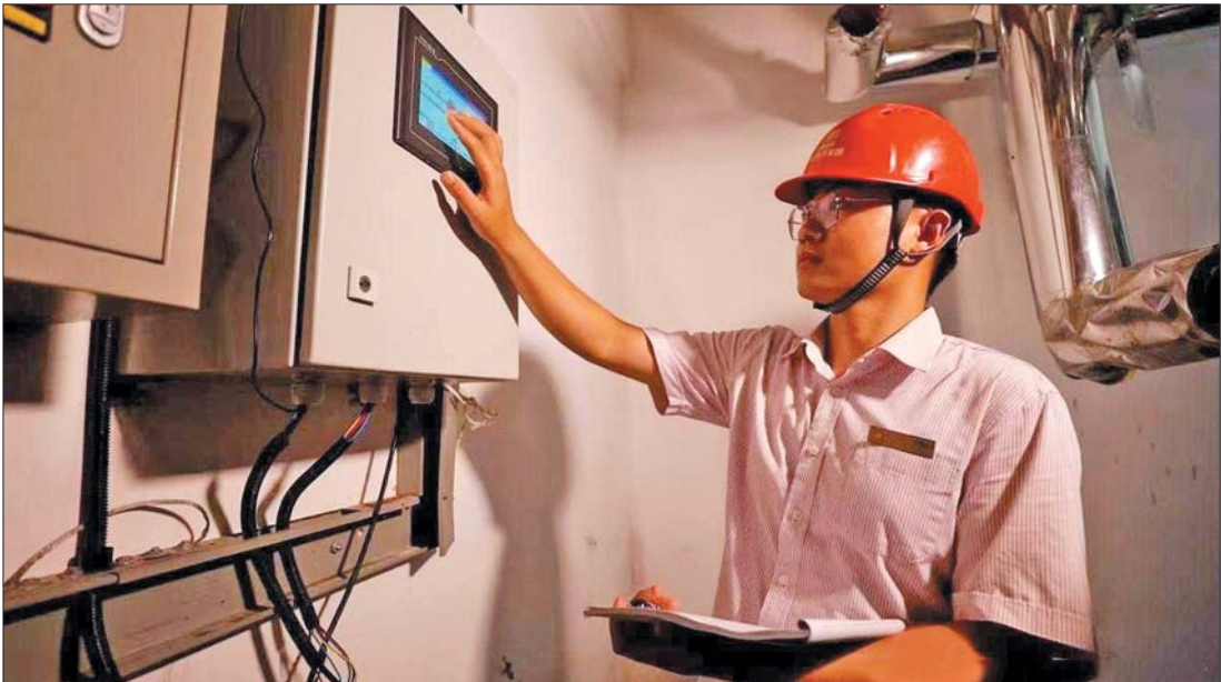
换热站工作人员在注水打压前对设备进行检查。
