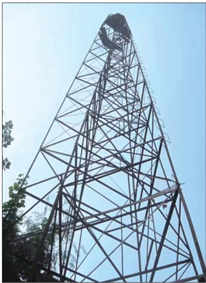
测量标志管护铁架。
