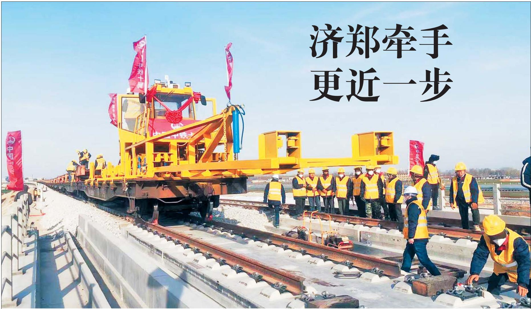
12月15日,济郑高铁山东段轨道工程全面开启铺轨建设。济郑高铁起自济南西站,止于郑州东站,是山东“四横六纵”综合运输通道的组成部分。济郑高铁山东段铺轨工程起自京沪高铁济南西站,向西途经济南市槐荫区、市中区、长清区,德州市的齐河县,聊城市的茌平县、东昌府区、阳谷县和莘县,正线全长168.392km;共设车站5座,分别为接轨站济南西站、长清站、茌平南站、聊城西站和莘县站。济郑高铁山东段计划2023年12月底具备开通条件,届时济南至郑州列车运行仅需1.5小时。记者 王瑞超 摄影报道
