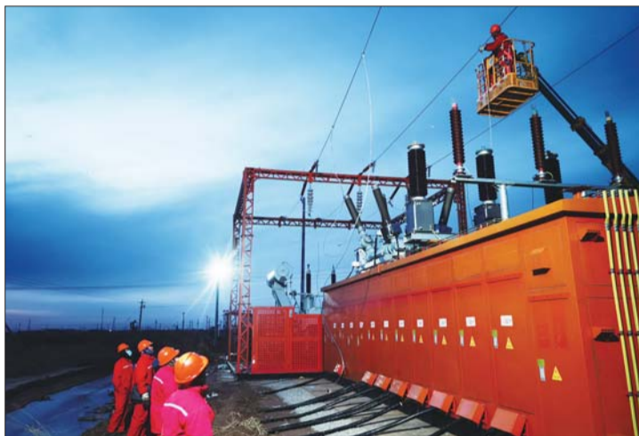
撬装式移动变电站安装。通讯员 冯泽慧 摄
