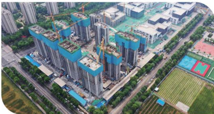
济宁高新区国际人才港(公寓)项目。
