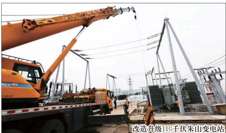
重点项目保电现场
