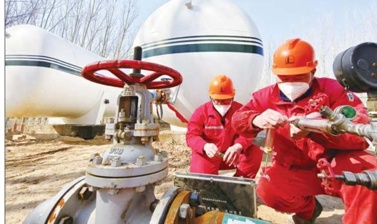
近年来,胜利油田滨南采油厂以绿色企业行动计划为统领,围绕降能耗和碳减排目标,加强危废源头减量和资源化利用,开展二氧化碳回收处理项目,助力“无废”油田建设。其中,滨南采油厂在平方王油田输油干线上建设了一座气体处理站,对油井伴生气进行分离、提纯、液化。项目自2022年底投产至今,日处理伴生气约3万立方米,日产液态二氧化碳50吨、甲烷气5000立方米,可提供给兄弟单位进行生产再利用,预计全年创效361万元,实现清洁生产和经济效益双丰收。本报记者 顾松 通讯员 肖金禄 华瑞雨 摄影报道
