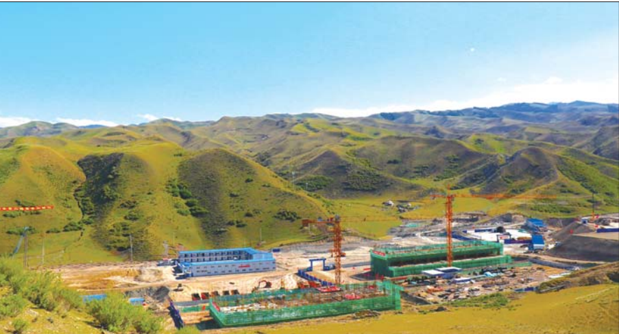
正在加快建设中的白杨河煤矿。
