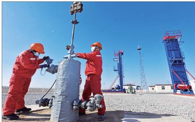
近日，胜利油田河口采油管理四区注采401站员工，对治理后的BAE12-斜14井进行有效维护，确保其安全高效生产。据了解，BAE12-斜14井治理前因供液不足，日产原油不足0.2吨。在低效井治理工作中，他们按照“一井一策”的原则，通过压驱补能恢复地层能量，该井日增油7.9吨，目前已累计增油1110吨。
