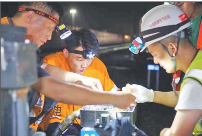
国铁济南局济南电务段作业人员正在拆除部分既有电缆,连接新电缆。 通讯员 郭旭 摄
