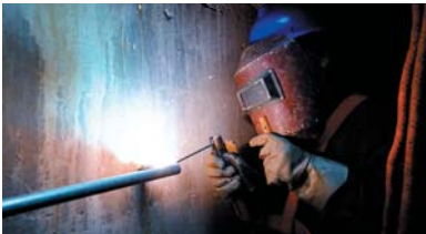
东泰热力维护人员在热力井内进行焊接工作。
