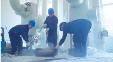
换热站内，东泰热力维护人员用高压水枪对除污器滤网进行清洗。
