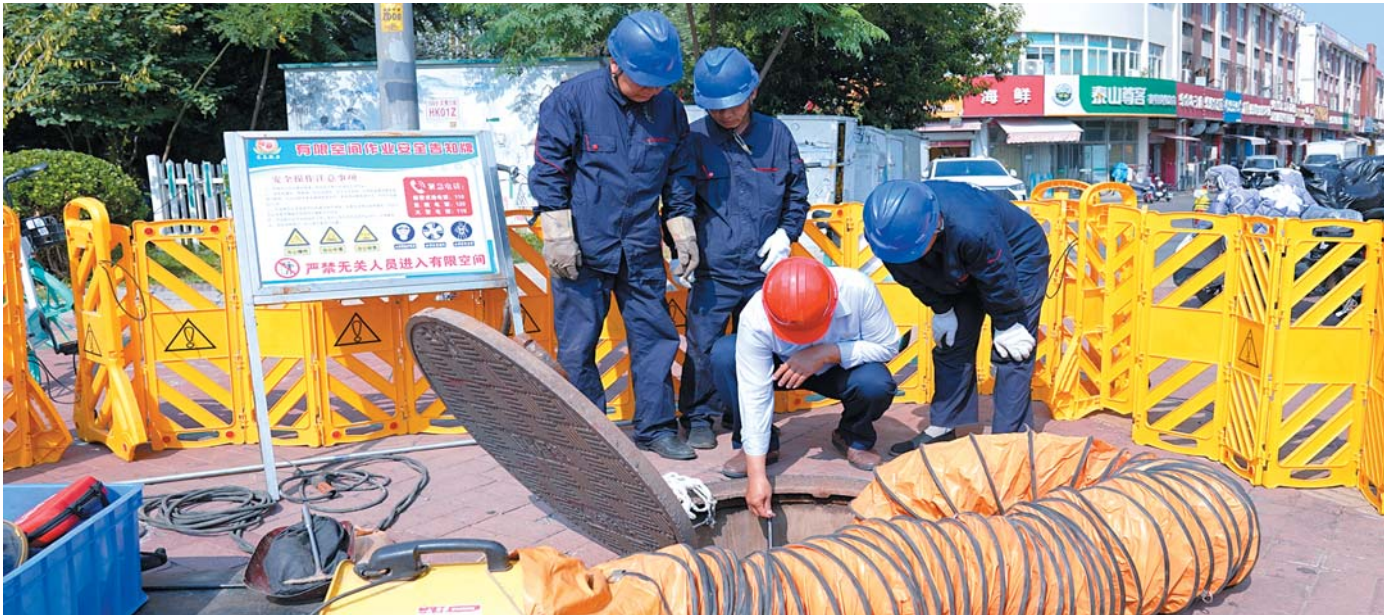
有限空间作业前，东泰热力维护人员对有限空间进行通风和气体检测。
