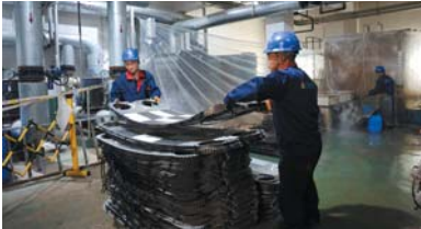
东泰热力工作人员将清洗干净的换热器板片摆放整齐，做好安装前准备。
