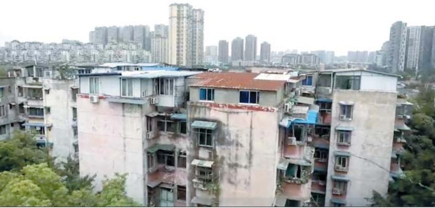
小区随处可见墙体开裂、墙皮脱落现象。
