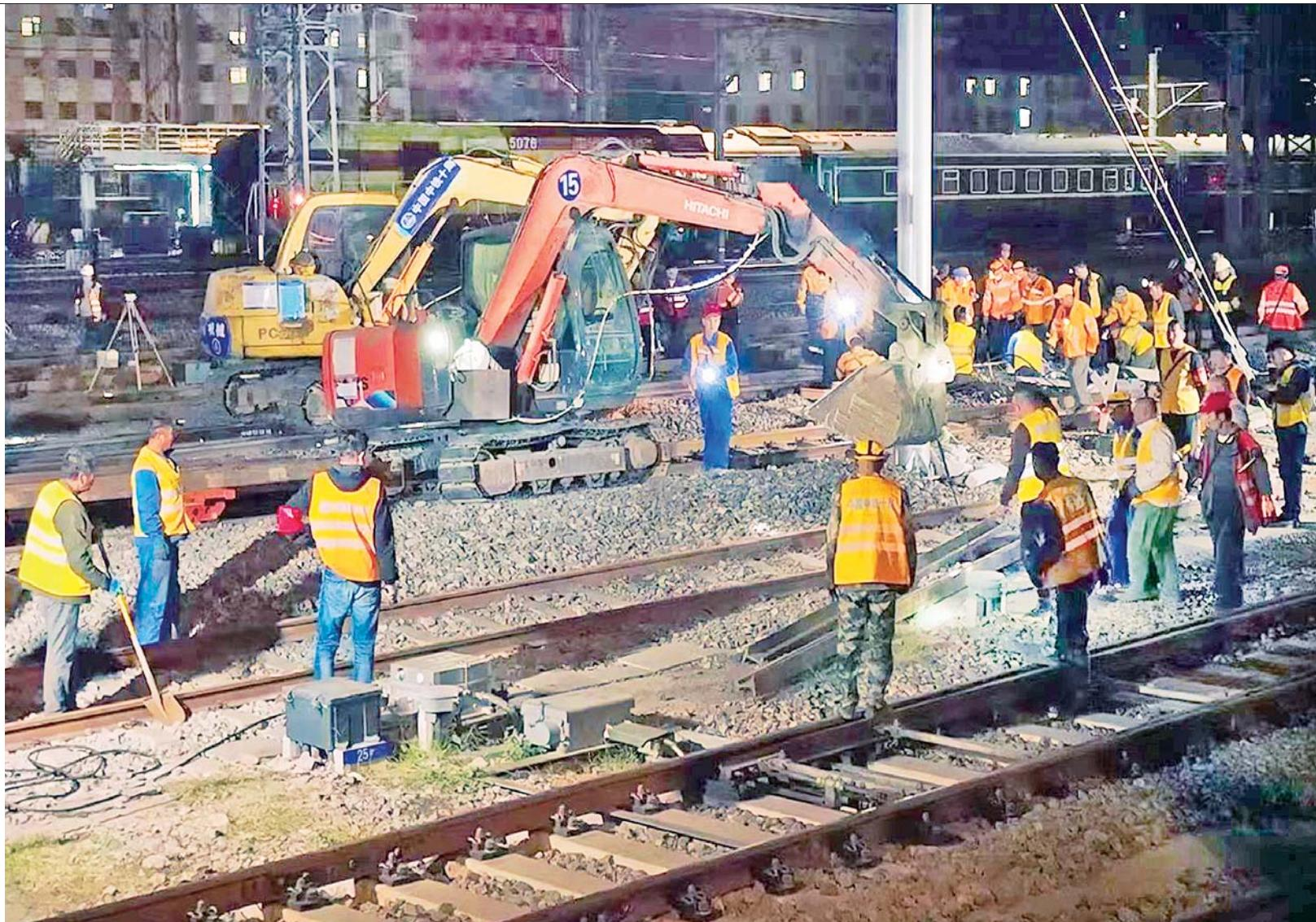
10月19日凌晨,随着施工人员进入,济南火车站迎十年来最大规模站场改造。此次改造施工,把济郑高铁山东段正式引入济南站、大明湖站和济南东站,将实现济南西站、济南站、大明湖站和济南东站四座车站真正连通,形成“三主一辅”客运站格局。改造完成后,济南站客运规模将由现在的4台7线变为5台8线,同时新建站台将连通正在建设的济南站新增北站房,大大提升客运能力。记者 李牧青 通讯员 邵帅 房从义 韩笑 摄影报道
