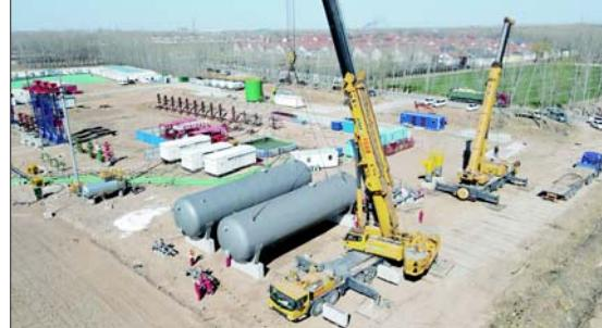
近日，在胜利油田鲁明公司滨435块二期产能建设现场，滨南采油管理区员工正在进行油气分离缓冲罐吊装作业。据了解，滨435块二期产能建设中，鲁明公司与滨州市滨城区政府密切沟通，采取提前铺设进井道路等措施，确保区块产能建设顺利推进。
