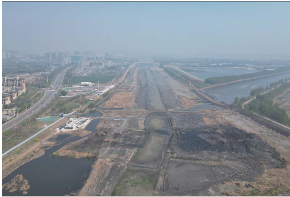
项目橡胶坝主体施工。
