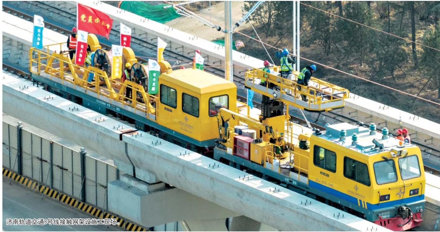
济南轨道交通3号线接触网架设施工现场。
