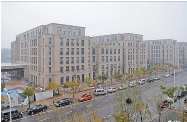
正在建设中的河南省宋庆龄基金会建筑群,“宋庆龄艺术雕像”坐落于该建筑的南广场。新华社发
