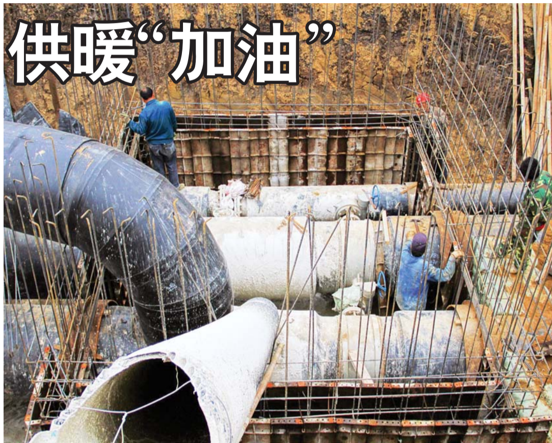
11月8日下午，西线泵站施工现场，工人正在紧张施工建设。 据了解，为改善热网系统的水力平衡，提高供热质量，蓝天热力公司在主管网东、西线分别增设两座中继泵站。 东线中继泵站位于北城新区澜泊湾广场西侧，是东线主管网过河后的“加油站”，泵站主体及设备安装9月28日全部竣工，10月7日与主管网抽口对接完成。西线泵站位于通达路与兰山路交会处东100米路南，项目于10月1日开工建设，目前正在加紧施工。
