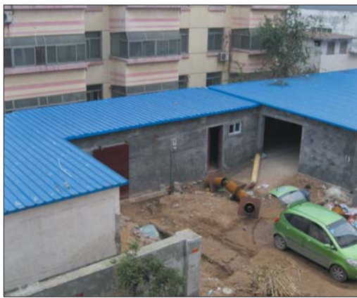
换热站紧挨北边的工业贸易公司家属楼。本报记者 焦守广 摄
