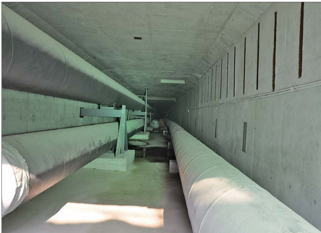
二环西路已成形的地下综合管廊,好宽敞,好场面。 本报记者 王光照 摄
