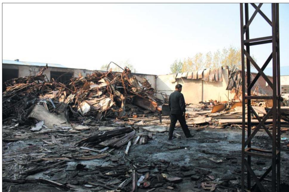
板厂被烧成一片废墟。
