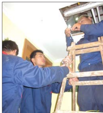
舜玉花园小区物业给业主维修中央空调。 本报记者 孟敏 摄
