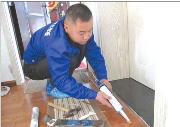
宏耐地板维修工正在居民家中修地板。侯艳艳 摄
