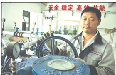
在供热厂间,一名工人在调节供热流量阀门来控制温度。本报记者 熊戈 摄
