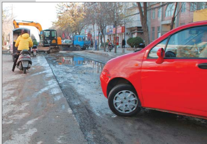
城区主要路段暖气改造工程陆续完工
