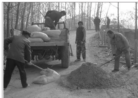
工人正在施工。 本报记者 胡修文 摄
