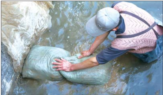
维修队的工作人员正在对两个通流口进行填堵。 本报记者 王媛媛 摄
