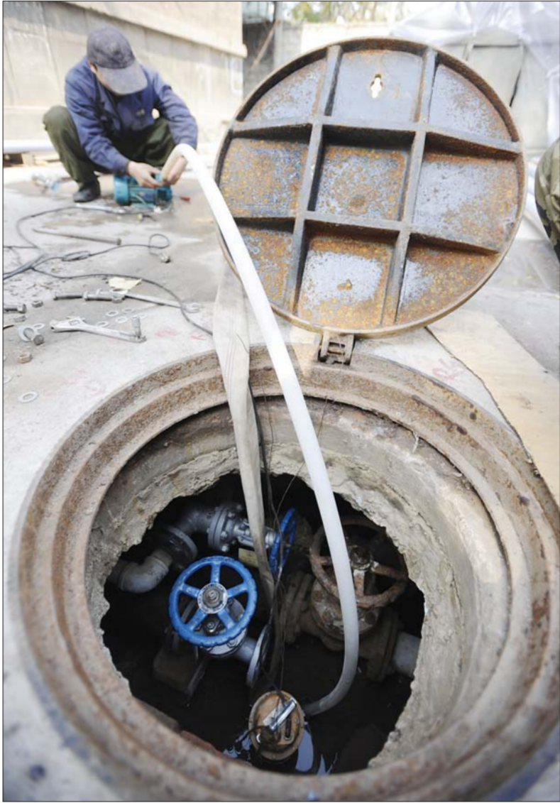
在甸柳片区的供暖管道前,工作人员正在抢修漏水的管道。 本报记者 王媛 摄
