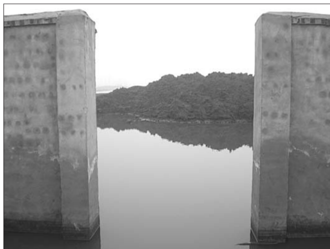
煤场被水淹,煤泥难运出。 韩伟杰 摄
