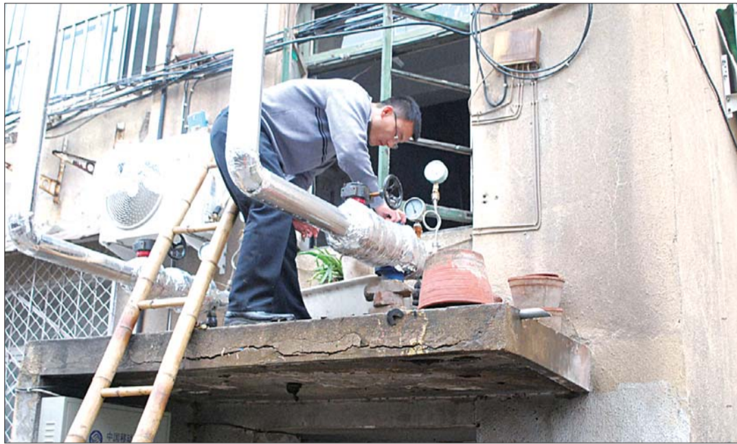
在刘庄小区内,一位维修人员正在对阀门进行检查。本报记者 马辉 摄
