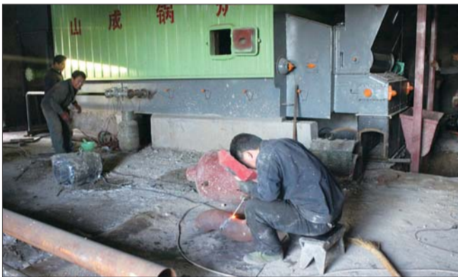
山成锅炉的孙师傅在焊接锅炉管线。 本报首席记者 聂金刚 摄
