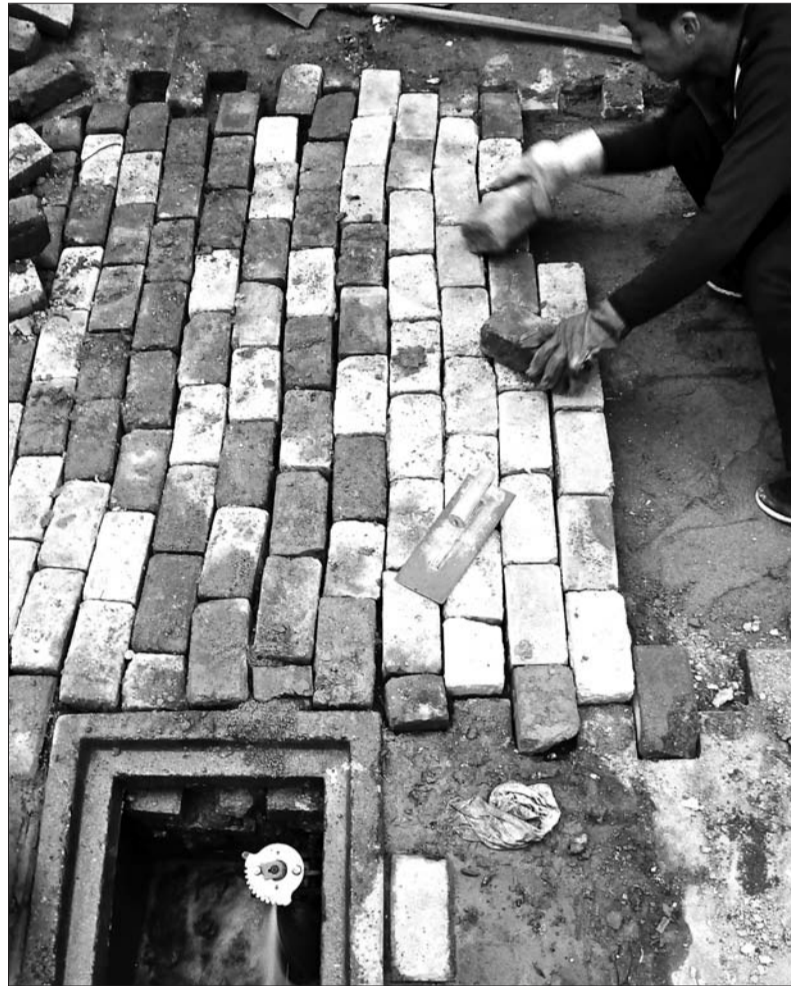
11月15日,在德州一使用地暖的小区中,施工人员正在修补放水处的地面。供暖开始,使用地暖的小区开始放回流水,以预热暖气管道。
