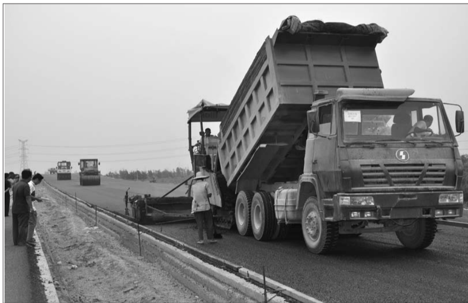
建设中的滨德高速。(资料片)
