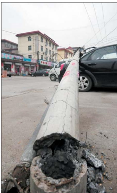
电线杆从底部断裂后,砸中汽车。
