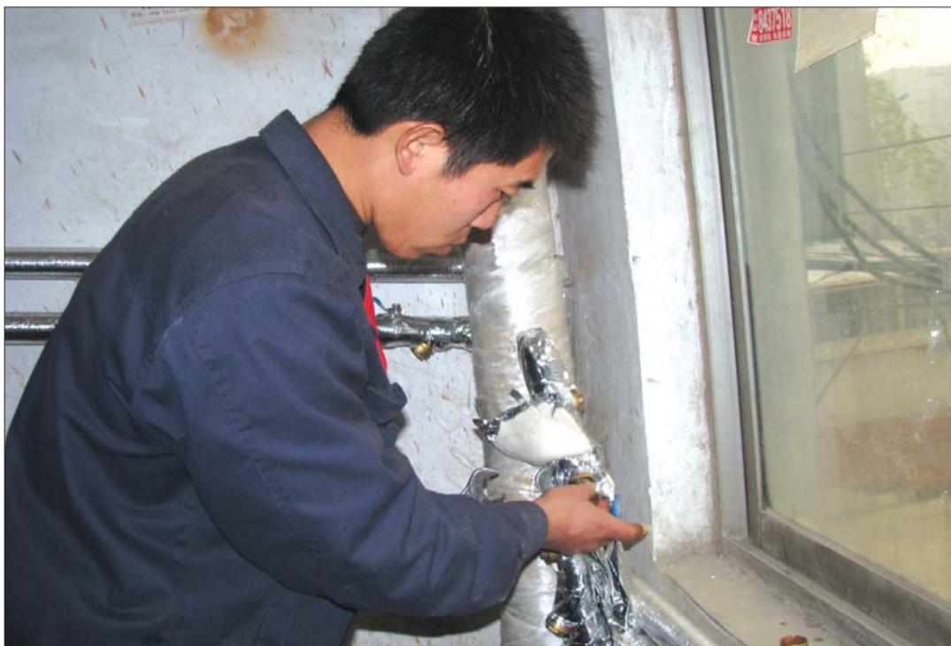
热力维修工正在清理除污器。本报记者 王颜 摄
