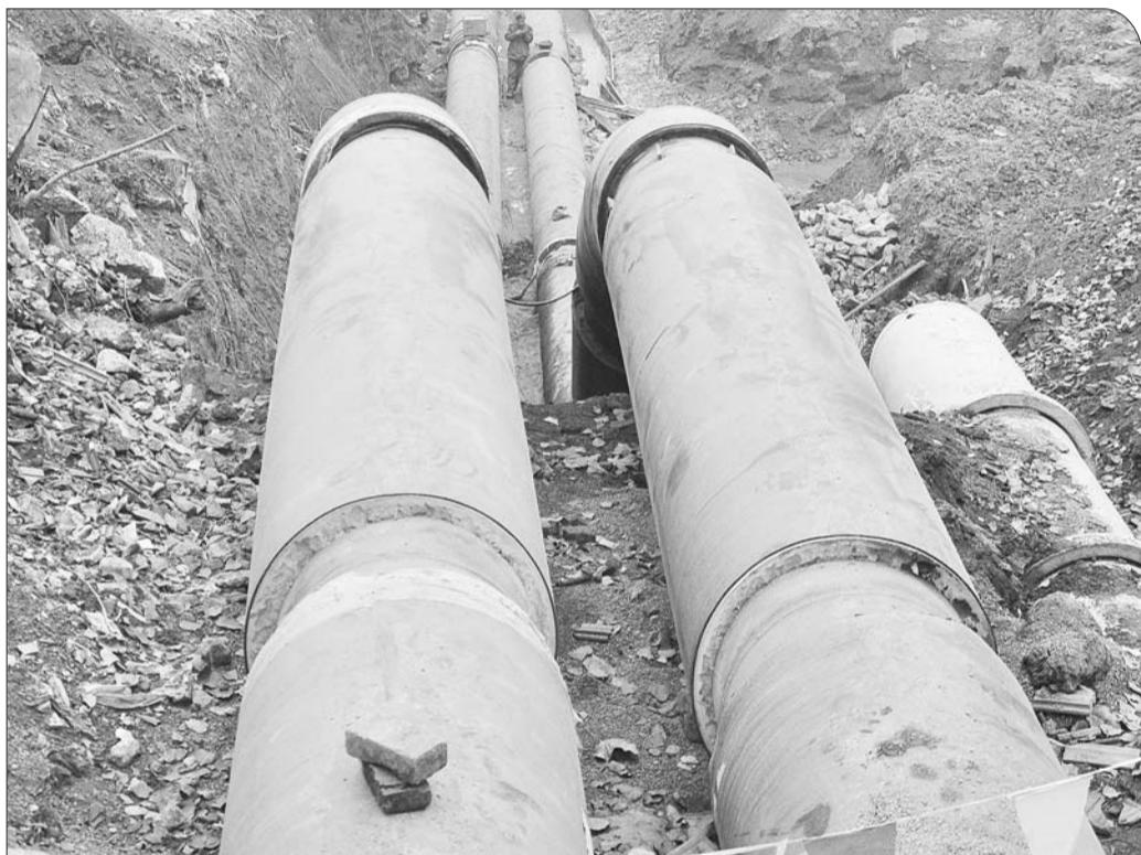
▲施工现场,工作人员正在施工作业。本报记者 武春澍 李焱 摄
