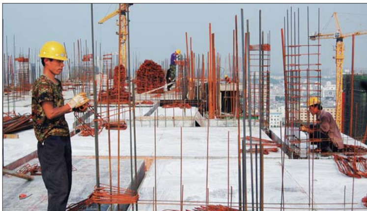
▲建筑工地施工现场。(本报资料图 邓兴宇 摄)
