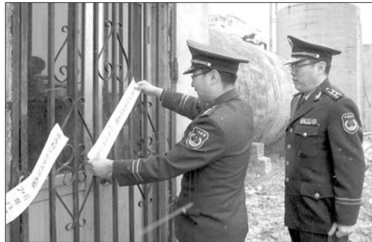
经区消防大队工作人员对加油设施进行临时查封。
