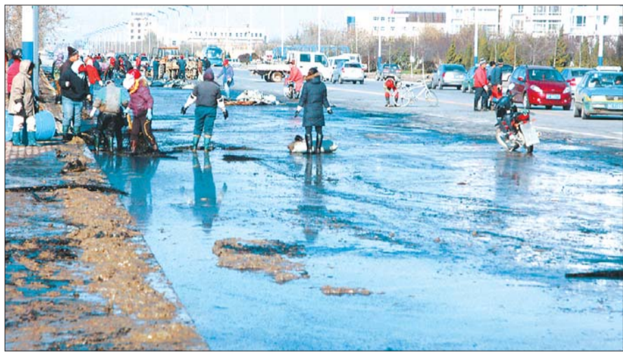
东营市西一路上有200余米的油迹,截至发稿前原油已经收回,路面也已清洗完毕。本报记者段学虎摄
