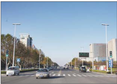
图为正阳中路智能交通信号系统灯杆。 胡永绪 摄
