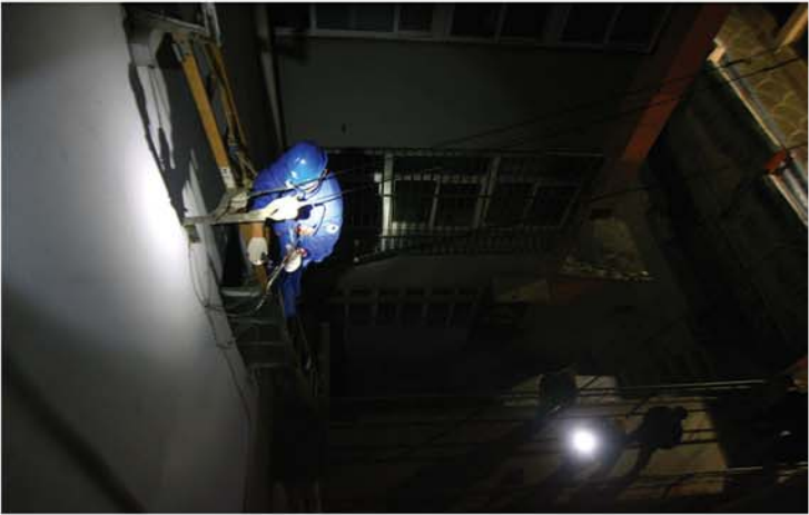
寒夜里,抢修人员在手电照明下抢修烧断的电缆。
