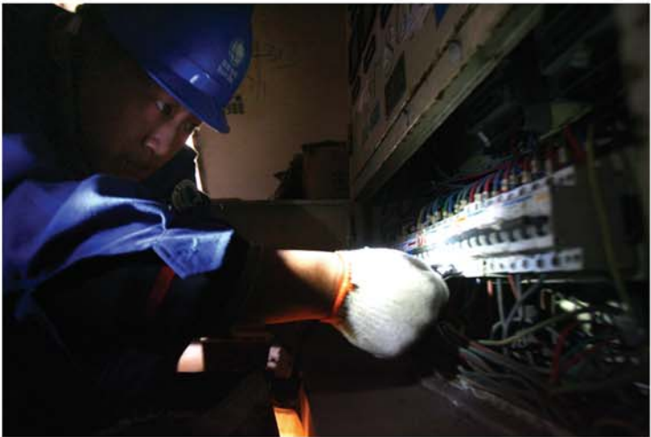
有时断电故障只是跳闸,推上电闸就通电了。
