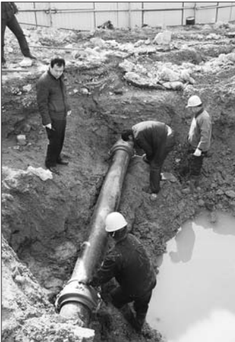
15日,市自来水公司的工作人员紧急抢修爆裂的供水管道。 记者 李玉涛 摄
