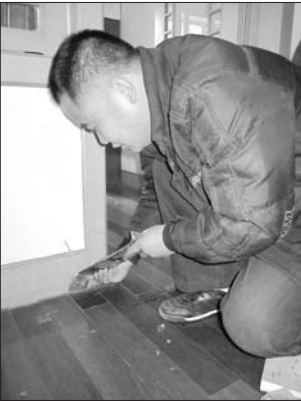
维修工在维修地板。 侯艳艳 摄
