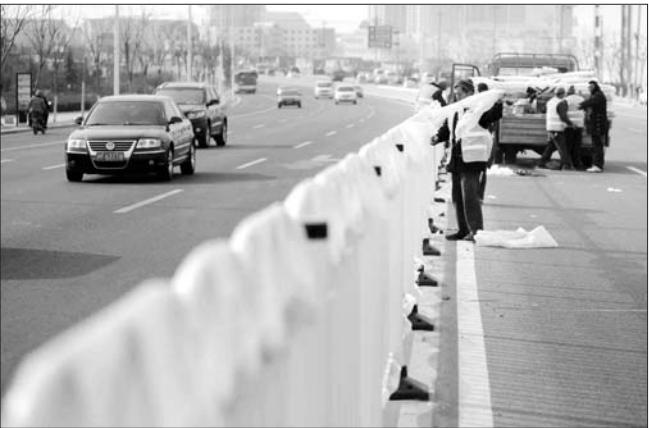
市政部门在香港东路安装隔离护栏。(资料片)
