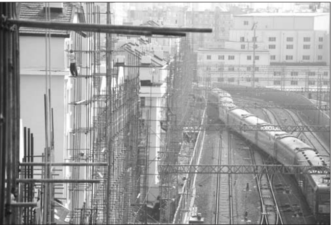
工人在脚手架上对火车道两侧的老楼房进行整修、粉刷外墙。(资料片)
