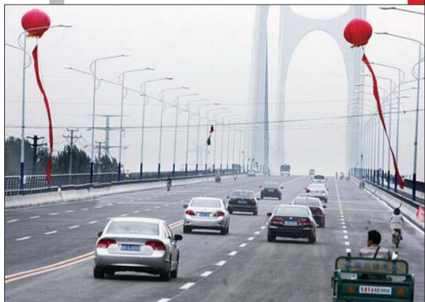
通车首日,在东大桥(洸府河大桥)上,车辆源源不断。本报记者 张晓科 摄
