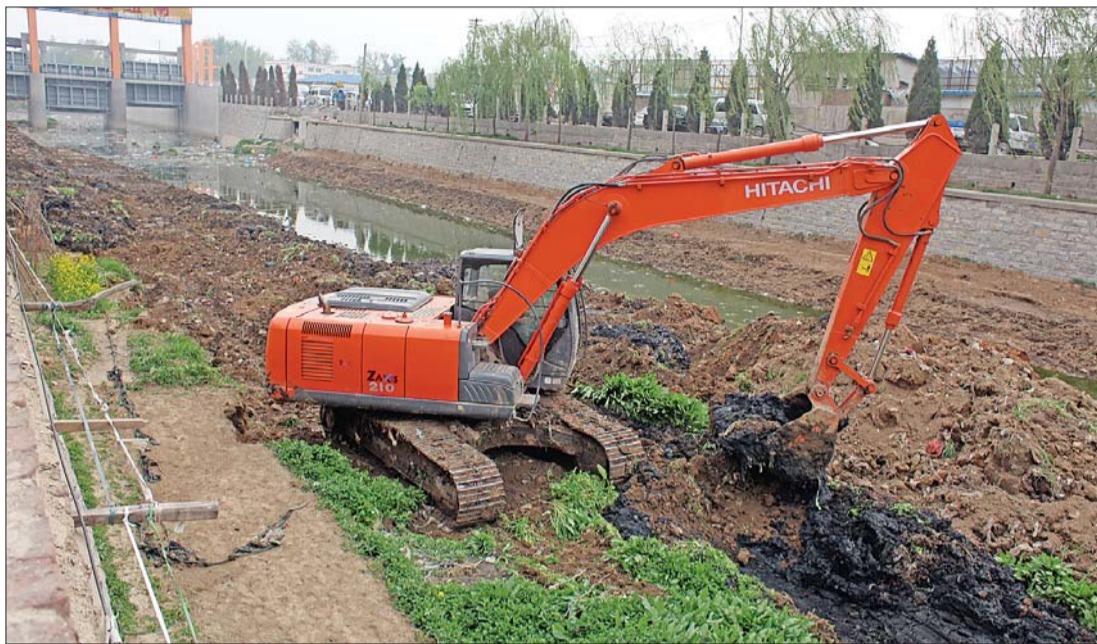
一台挖掘机正在清理河道里的淤泥。 本报记者 王鸿光 摄
