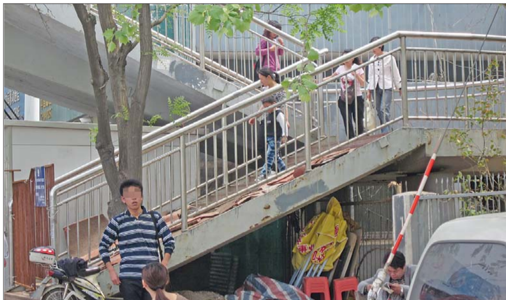
虽然封闭施工,仍有行人上桥。
