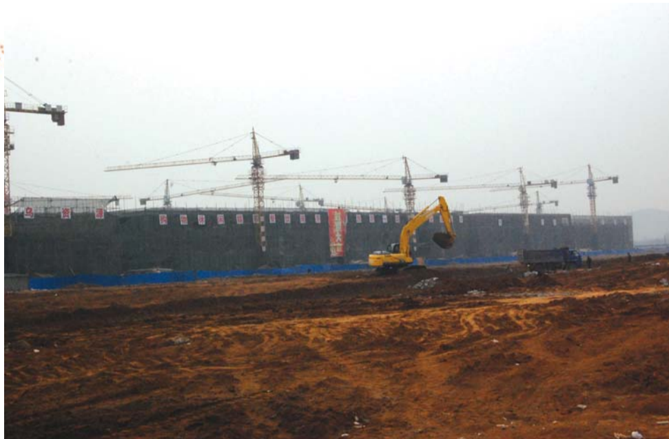
泰肥一级路上一家大型商业地产项目正在施工。
