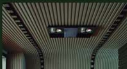
卫生间墙面、吊顶
