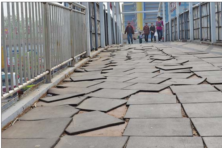
路面破损严重的济泺路过街天桥难道成了“孤儿”？ 本报记者 王光营 摄
