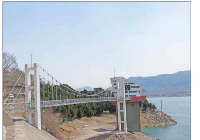
放水洞位于分层取水控制闸的下方,有高中低3处取水水位。
